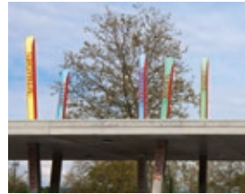
Seite 14 unterstützt wachsen Offene Stahlrohre verlängern Pfeiler des Vordachs
